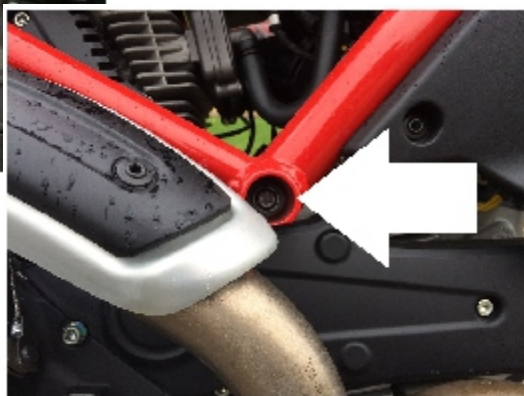
Miejsce montażu (prawa strona)
